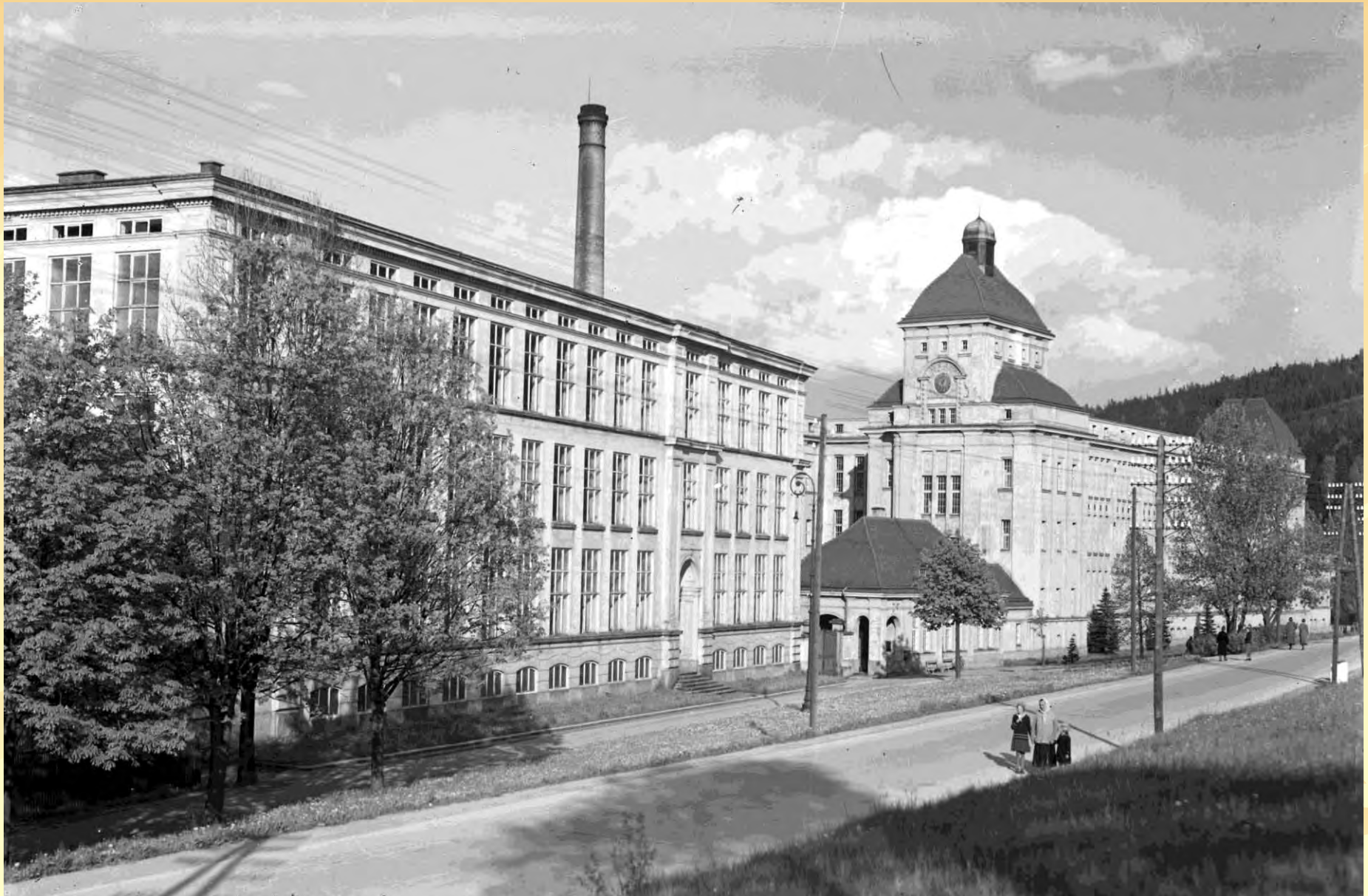
Budova bývalé textilní továrny Priebisch, archiv města Smržovka, 1933
